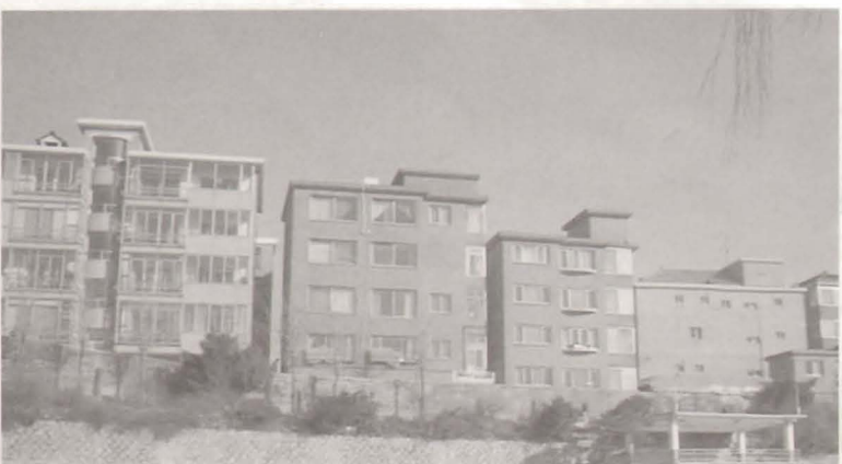
4층 건물(원서동 다세대주택)
