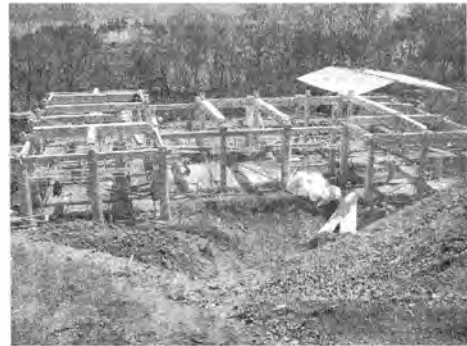
그림9. 목조가구식 구조의 조립 과정
